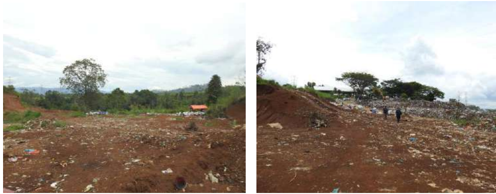
Gambar 5.15. Kondisi Eksisting Rencana Lokasi Unit Pengolahan
