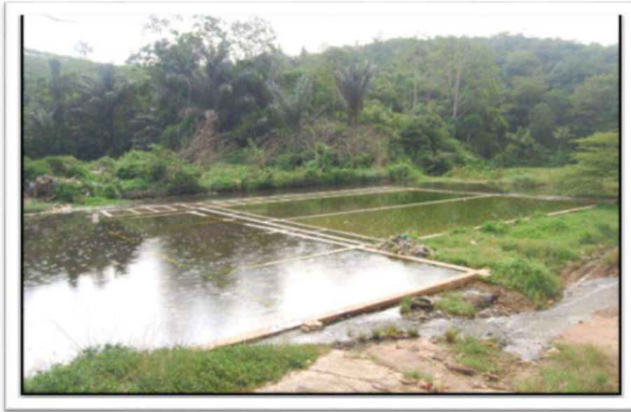
Gambar 2.6 Kondisi Kolam Lindi TPA Sampah Regional Payakumbuh
