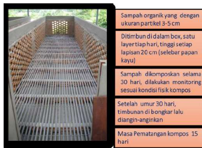
Gambar 4.18. Alur Kerja Pengomposan Menggunakan Metode Bata Berongga
