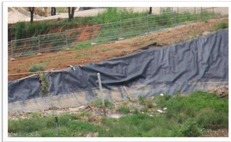
Gambar 2.5 Kondisi Lapisan Kedap Air pada TPA Sampah Regional Payakumbuh
