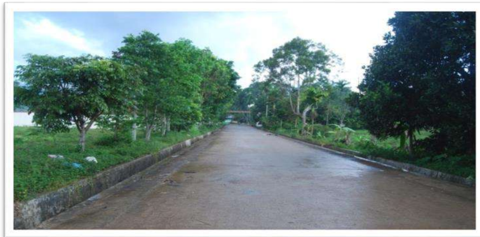
Gambar 2.3 Jalan Akses ke Lokasi TPA Sampah Regional Payakumbuh
